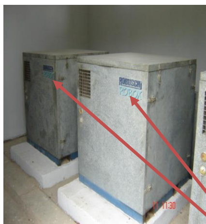
Surpresseur d'air de brassage : Dégradé (plusieurs réparations)
