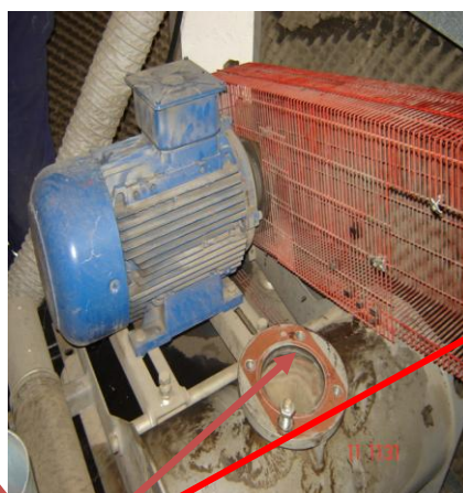
Surpresseur d'air de brassage : Dégradé (plusieurs réparations)
