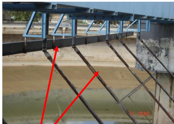
Corrosion avancée (plusieurs réparations)
