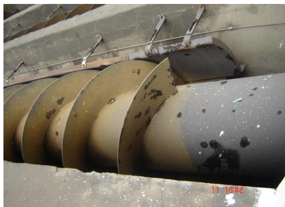
Vis d'Archimède (recirculation des boues) : Vétuste
