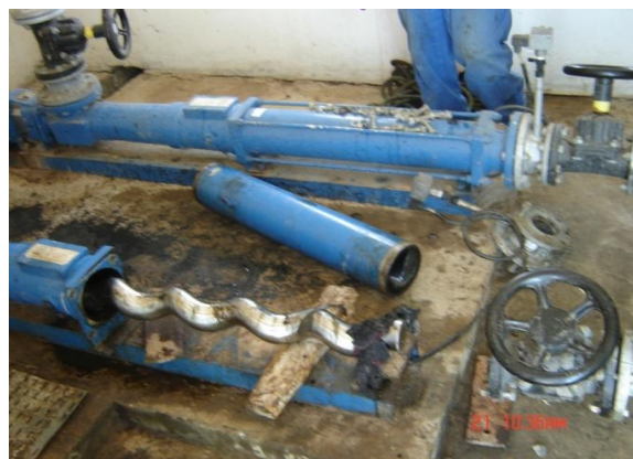
Pompe à boues épaissies : Vétuste (Plusieurs réparations)
