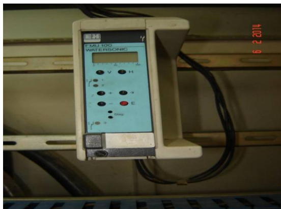
Système ultrason de niveau (Défectueux à l'arrêt)
