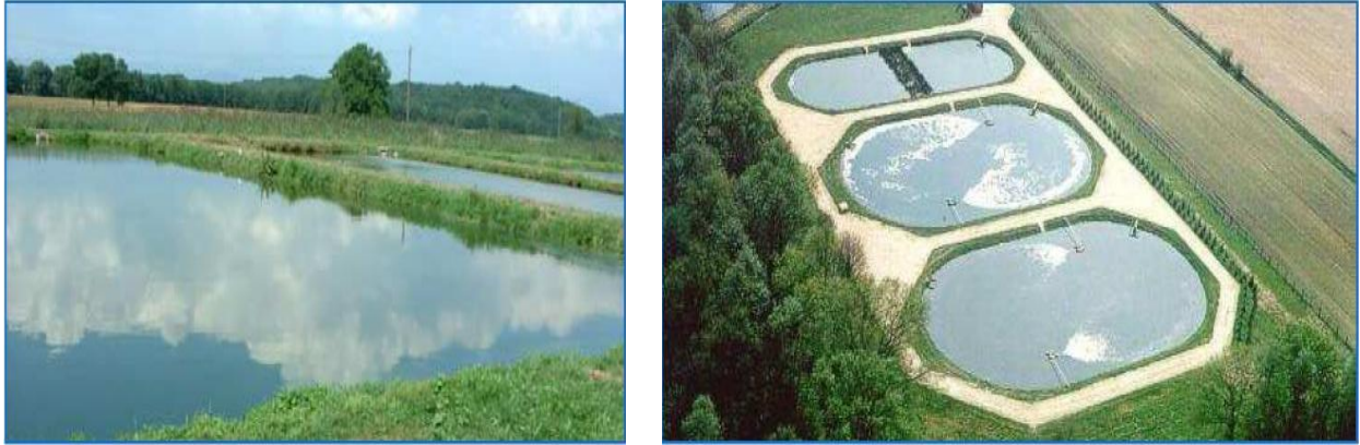
Figure III.10: Bassins du lagunage (lagunes)
